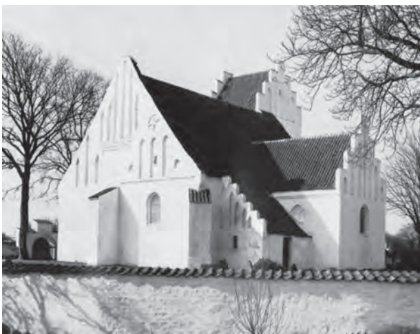
Fig. 6. Drøsselbjerg Kirke, set fra nordøst. Foruden tårnet foran skibets syddør blev kirken i middelalderen udvidet med et sideskib mod syd, forlænget mod øst og vest samt tilføjet et kapel og et sakristi på nordsiden. Efter Danmarks Kirker.
