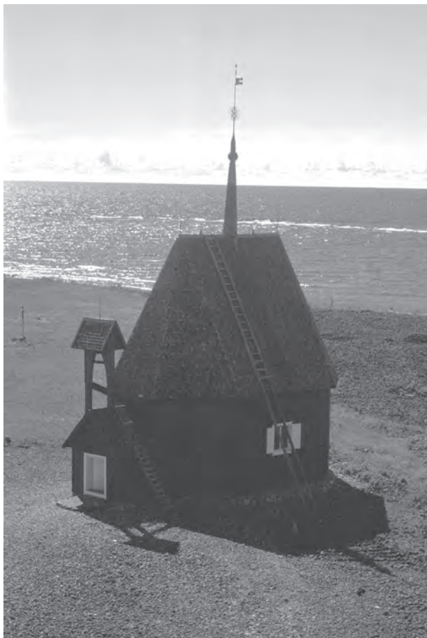
Fig. 12. Fiskarkapellet på Malören, Norrbotten, byggt 1799 av stadsborgare i Torneå. Foto: CW.
