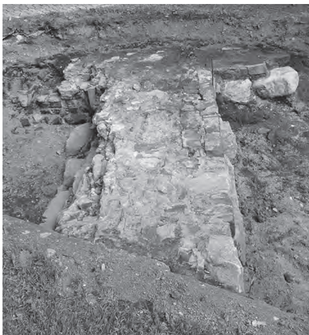
Fig. 8. Norra muren, strävpelaren (t v), valvpelaren (t h). Lägg märke till den raka innerkanten (t h) och den sönderbrutna yttersidan (t v). Foto 2004-06-09 från väster RC/Upplandsmuseet.
