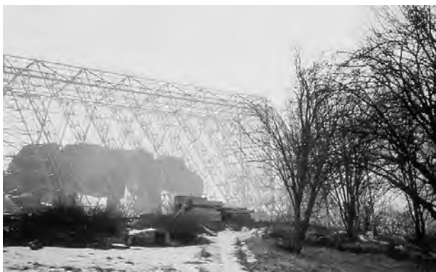
Fig. 3. Lund & Slaattos vernebygg over domkirkeruinene er en gjennomiktig telllignende konstruksjon av glass og stål med en trapesformet grunnflate. Foto: Berit J. Sellevold, februar 1998.
