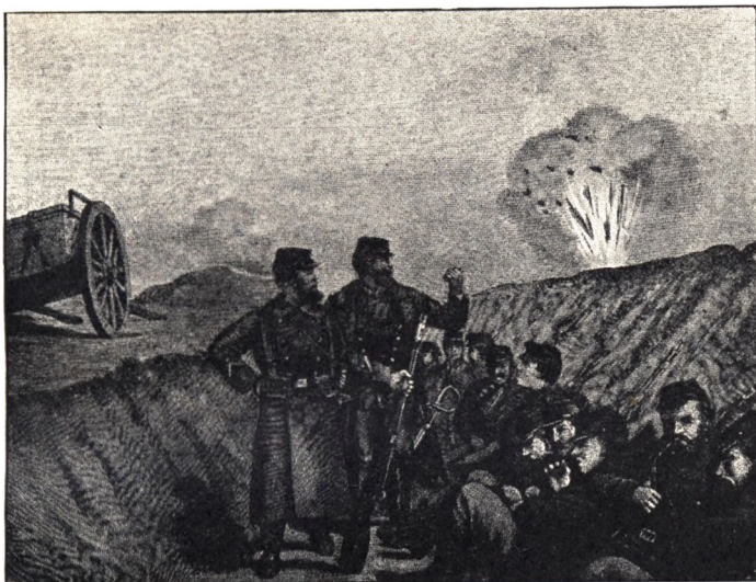
I en Løbegrav ved Dybbøl.
