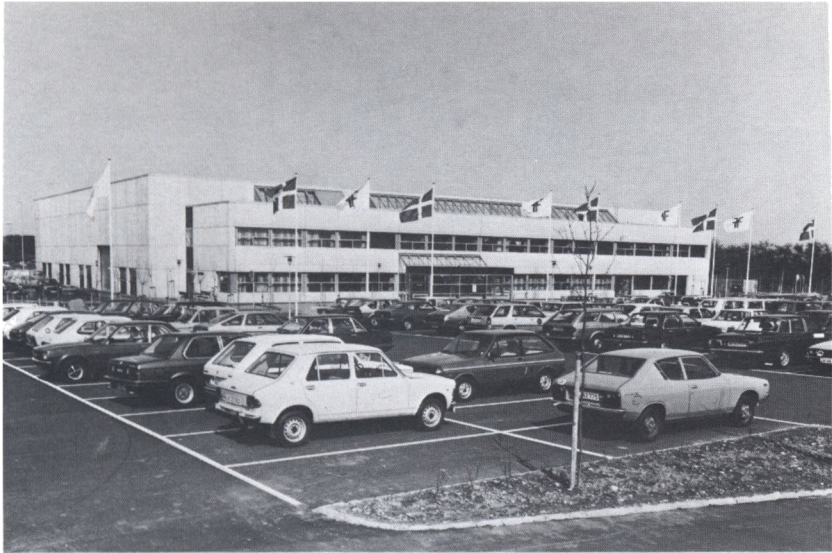
Det tidligere Fyns Forum på Sortebrødre Torv måtte vige pladsen for det nye kongrescenter, og det er siden opført som et moderne messecenter ved Ørbækvej sydøst for byen.
