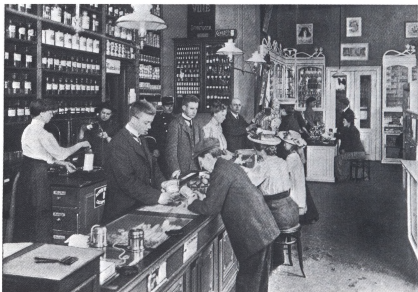
Interiør fra P. A. Kruuses materialhandel i den sydlige del af Provinsbankens nuværende bygning på Flakhaven 1907.
