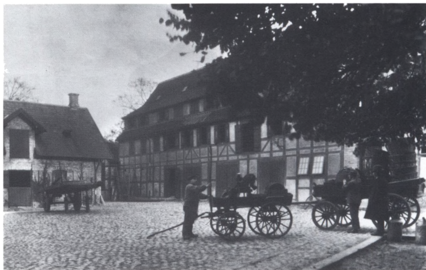
En af byens mange købmandsgårde var »Sukkergaarden« i Frederiksgade, hvis navn skyldes det sukkerkogeri, der 1761 anlagdes på stedet. 1840 købtes ejendommen af Elias B. Muus, der fandt den velegnet til indretning af en købmandsforretning. Pakhuset langs Christiansgade opførtes 1857-58.
