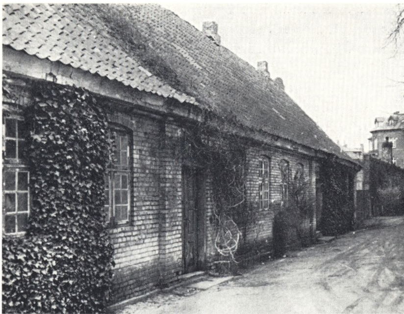
»Fruentimmerdaaren«, fotograferet kort tid før nedrivningen af bygningen i 1967, var den ene af de to bygninger på Gråbrødre Hospital, der rummede sindslidende. »Daaren« var den eneste institution af sin art i hele stiftet. (Fyns Presse Foto).
