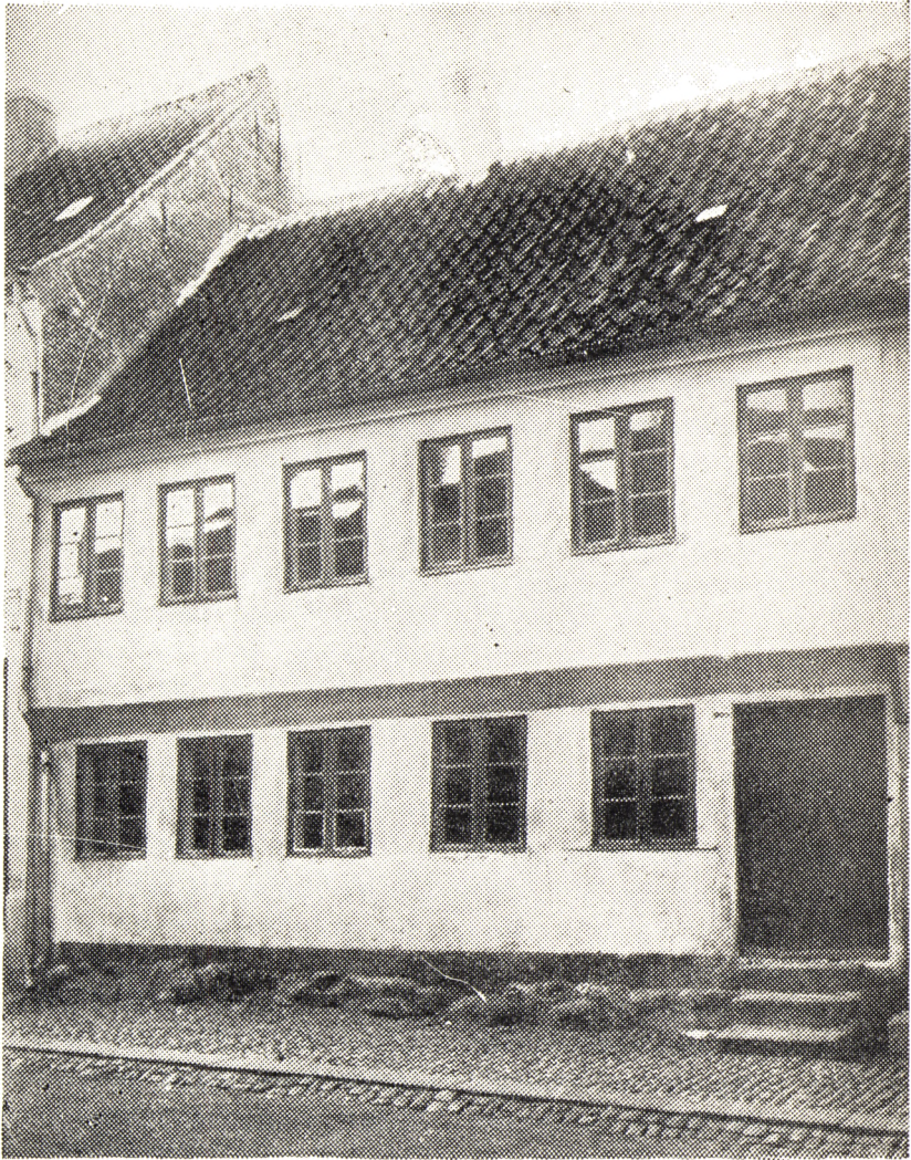
Huset i Algade, nedbrudt i Juni 1929.
