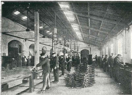
Interiør fra Fabrikken „Grand“s Lokaler til Samling af Cyklerammer.
