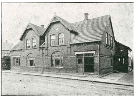
H. Schultz' Bøsemagerforretning & mekaniske Værksted.
