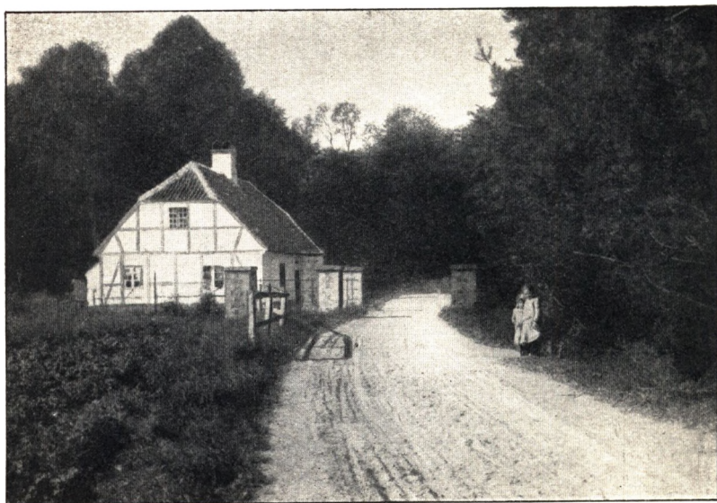
BROHUSE (INDKØRSEL TIL NÆSSET)
